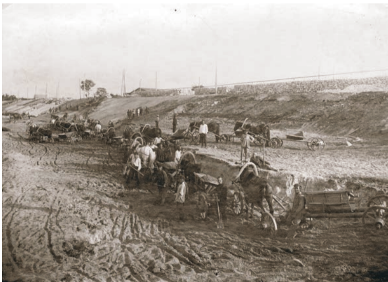
«Вид начальных работ по строительству бумкомбината»
