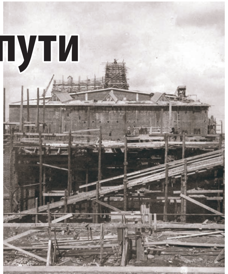
«Строительство здания бумкомбината»
